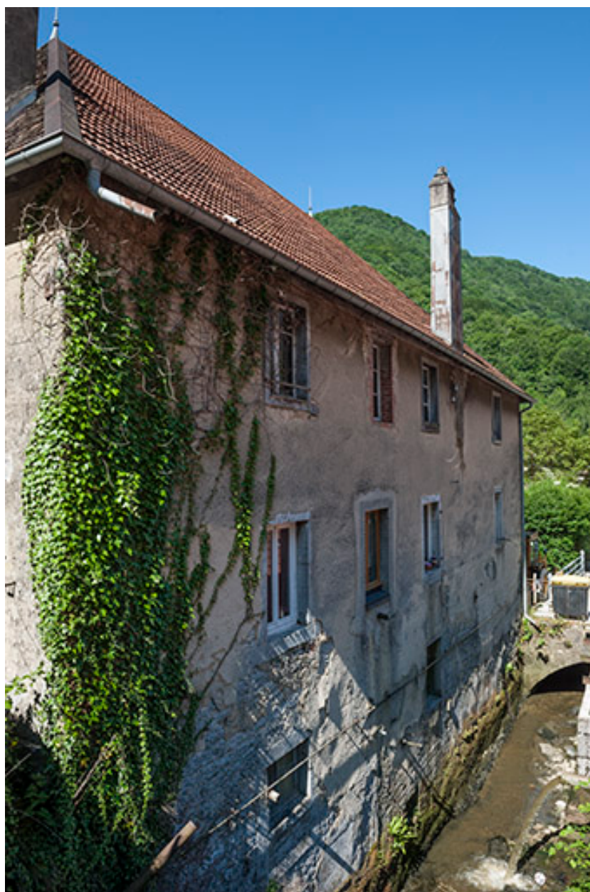
Façade nord du logement (ancien atelier).
