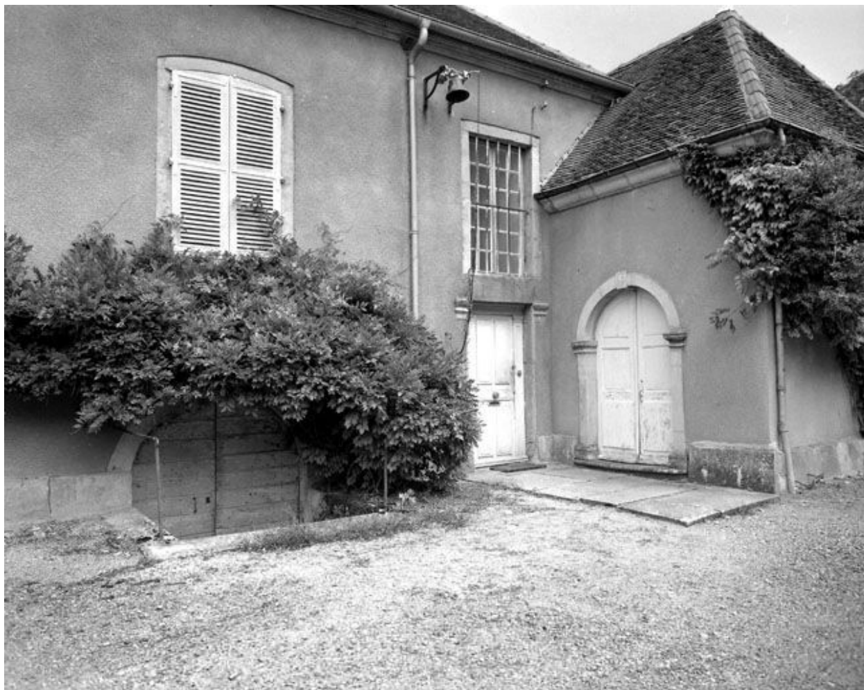
Façade antérieure du logis : partie droite.
