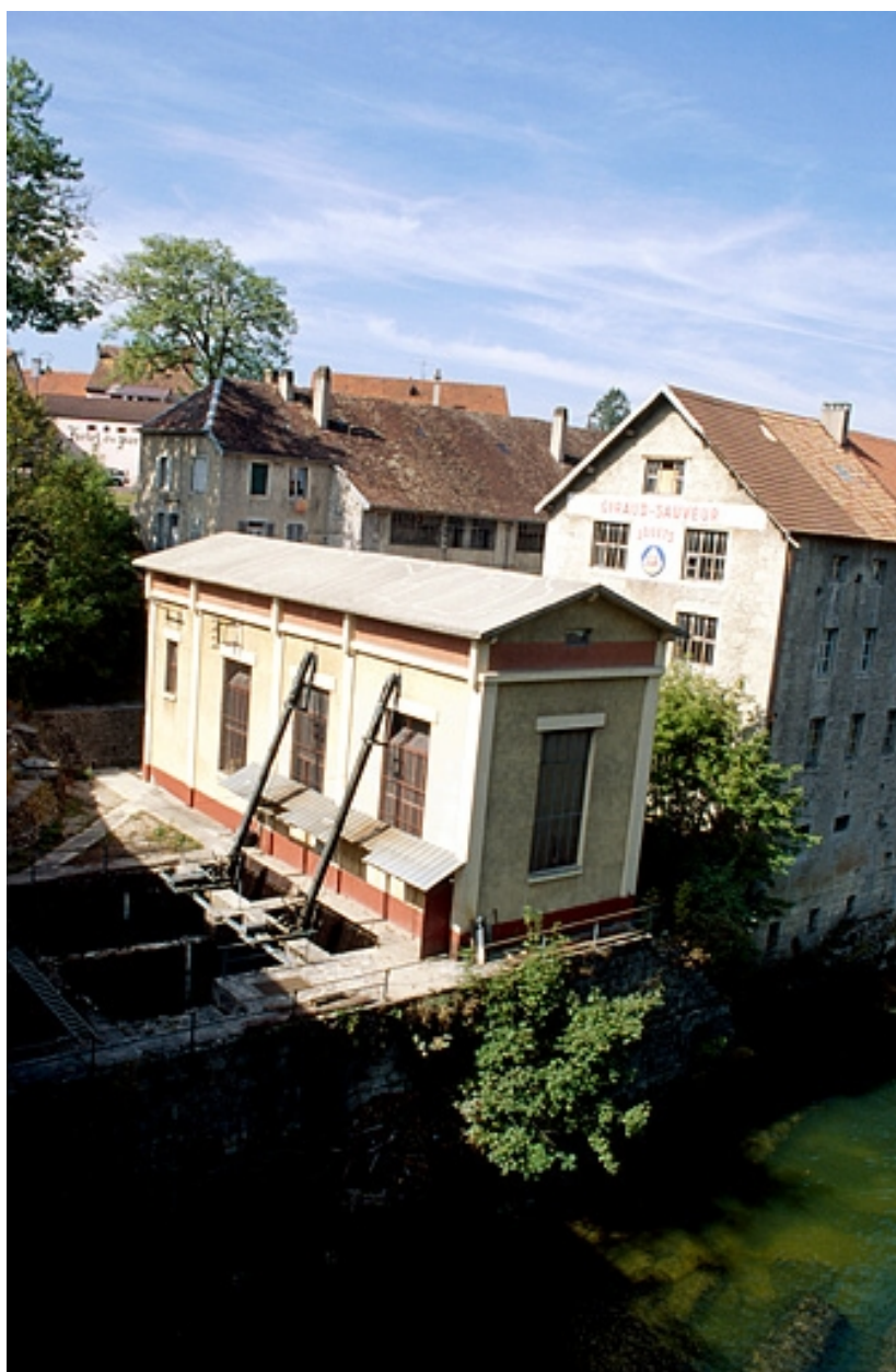
La centrale hydroélectrique.
