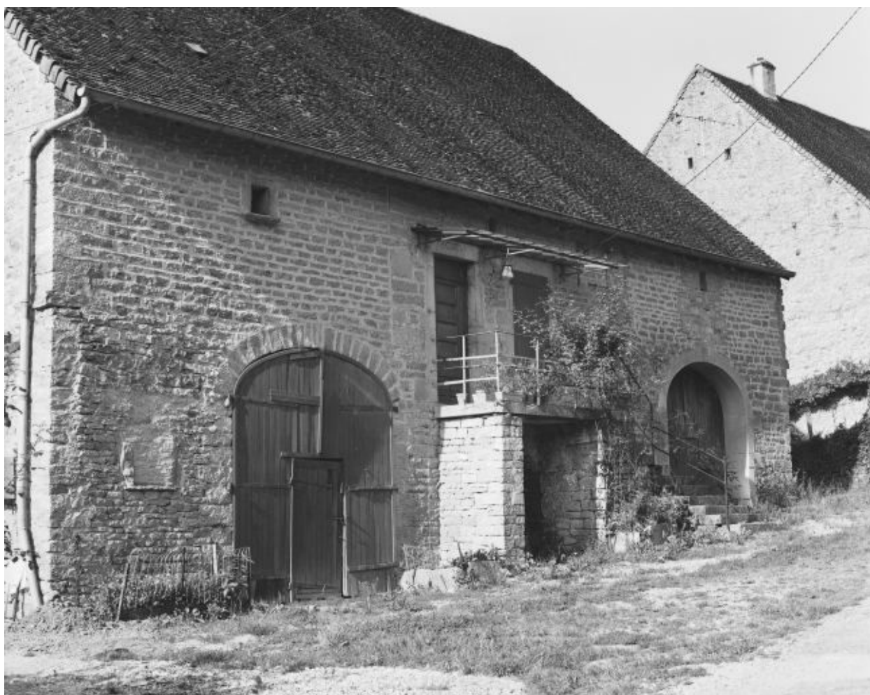
Ferme située rue du Bas du Village.
