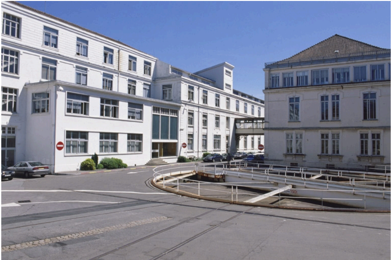
Vue d'ensemble des bureaux depuis le nord.
