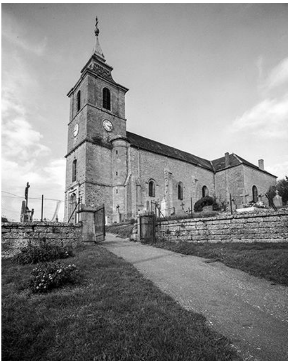
Tour-clocher et façade latérale droite.
