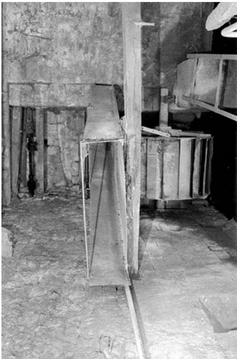
Roue en dessus et conduite d'amenée.
