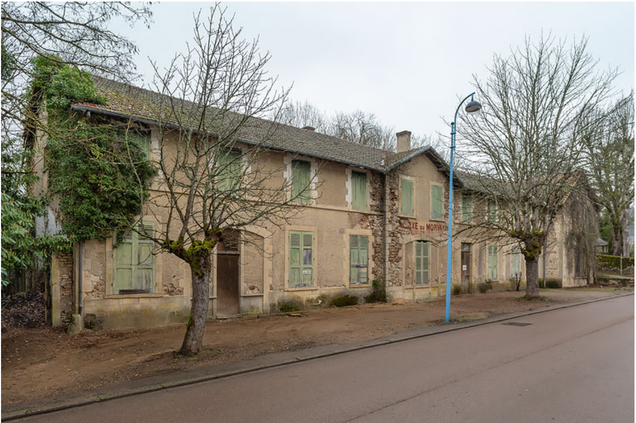
Façade principale, vue depuis le sud-ouest.
