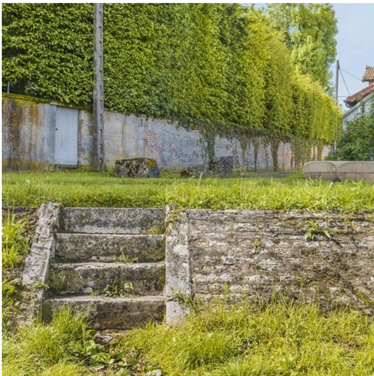
Deuxième escalier de la digue.
