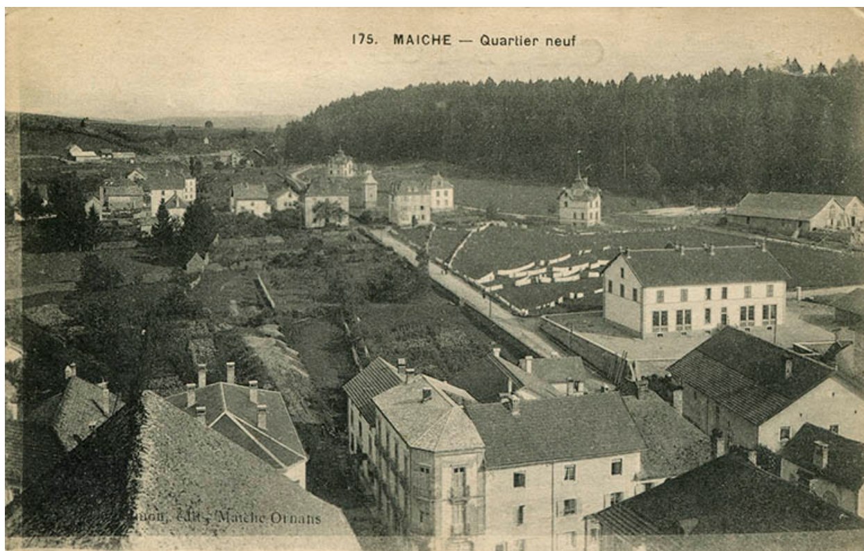
175. Maîche - Quartier neuf [vu du clocher de l'église, au nord-ouest], 1er quart 20e siècle.
