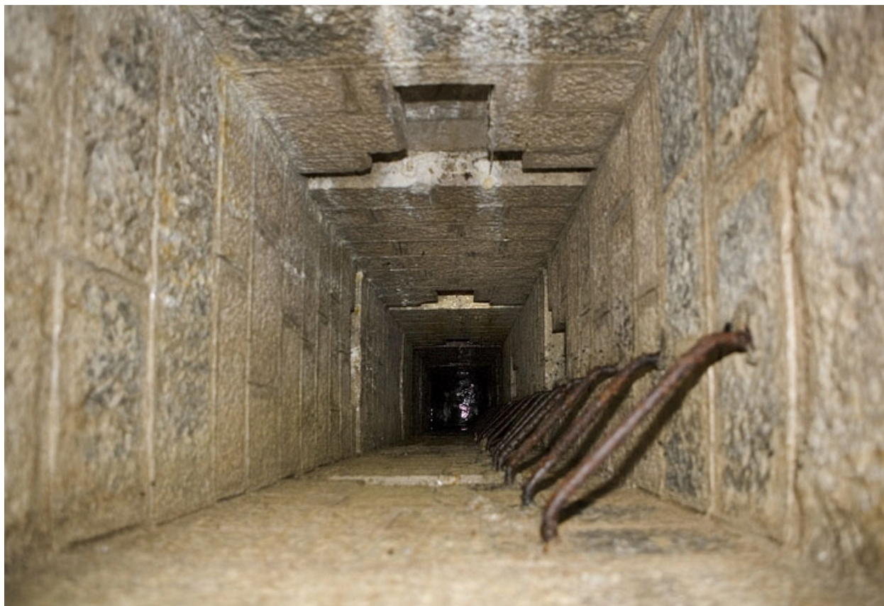
Chambres de mine sud-ouest : intérieur du puits.
