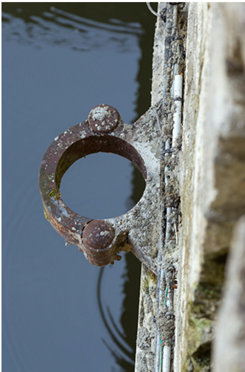
Gond d'une des anciennes portes du tunnel (entrée amont).
