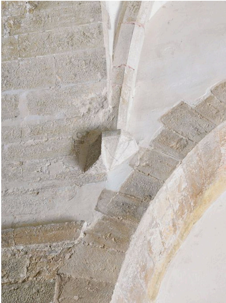
Culot de la voûte de la travée sous clocher.
