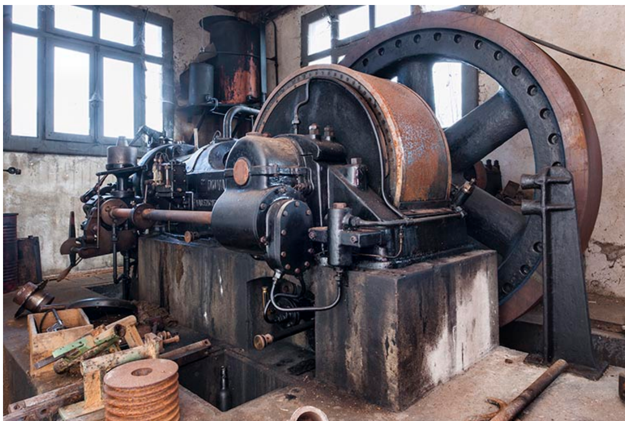
Moteur diesel Duvant.
