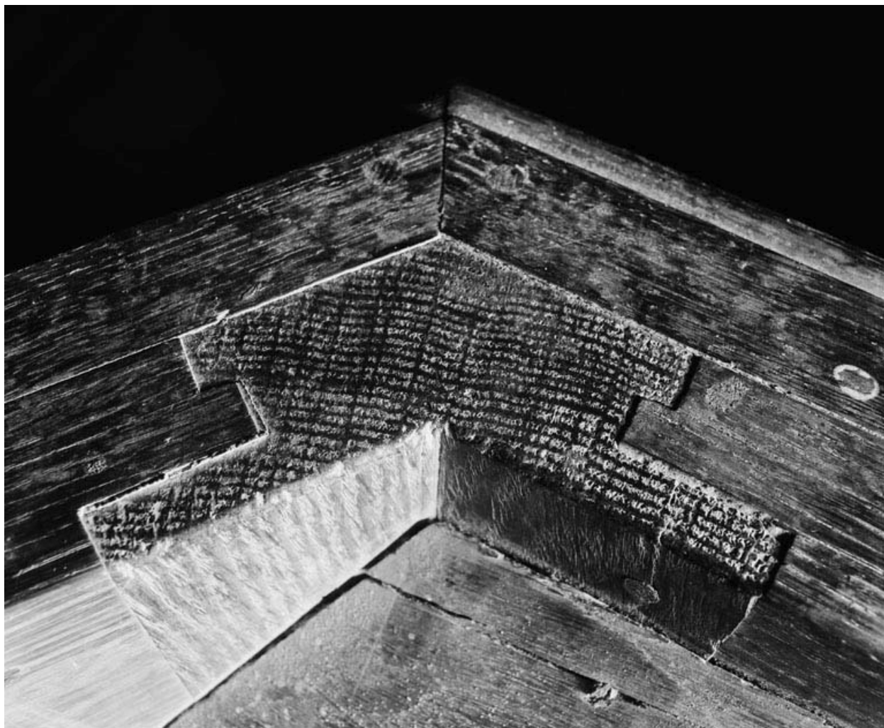
Détail de l'assemblage du bâti de la cuve.
