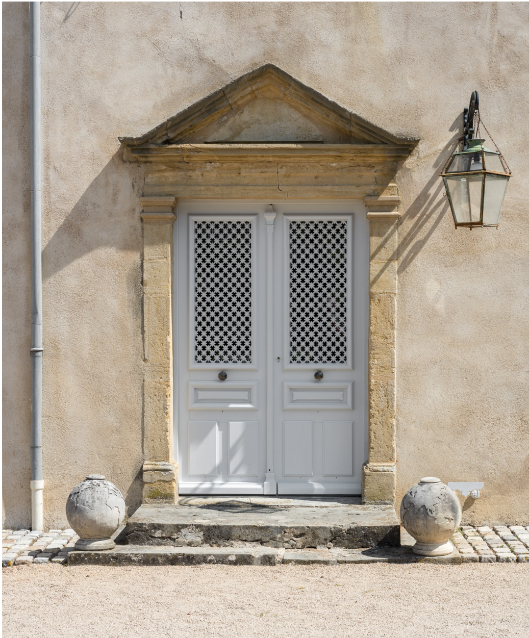
La porte d'entrée sur la façade antérieure : vue rapprochée.
