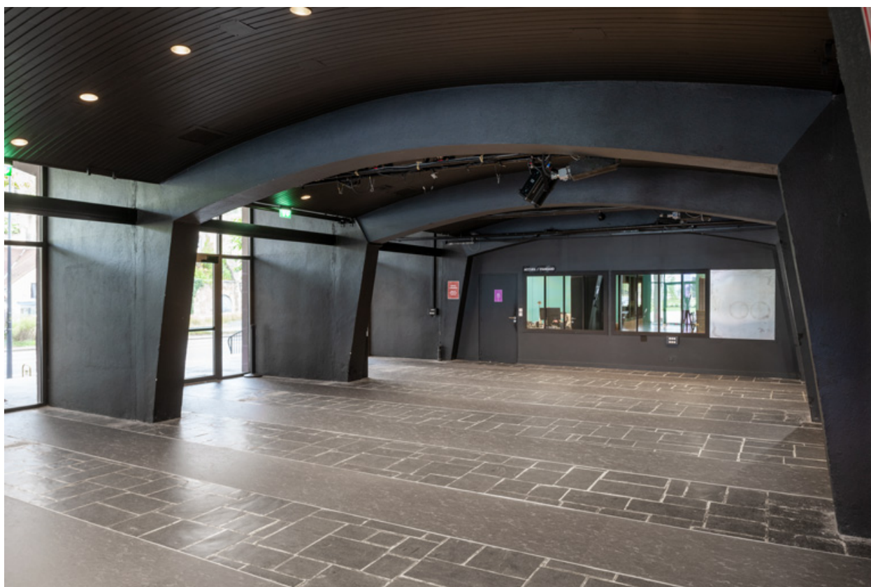
Maison de la culture : arcs de l'ancienne entrée.
