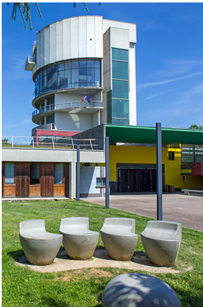
L'entrée et la tour depuis le sud-ouest.
