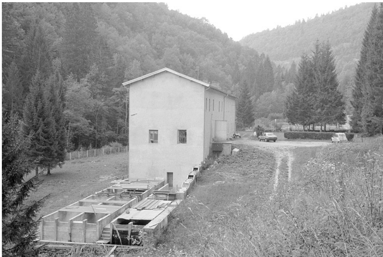
Bâtiment depuis le nord.
