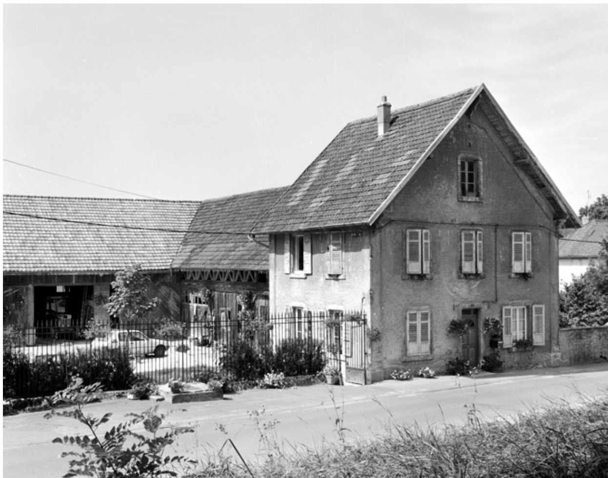
L'aile nord et le logement.
