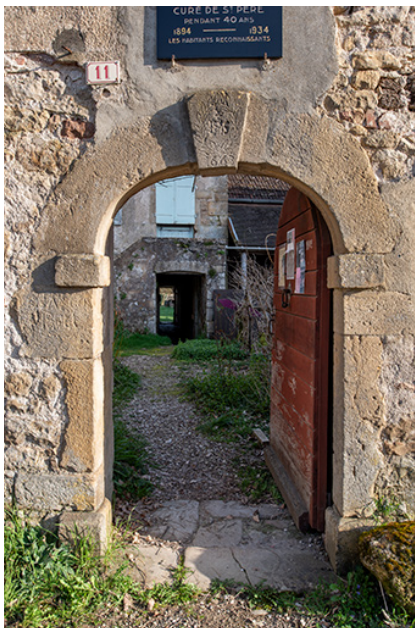
La porte piétonne du mur de clôture.
