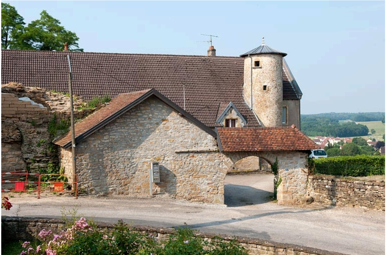
Vue d'ensemble depuis la rue du Quartier de la Citadelle.
