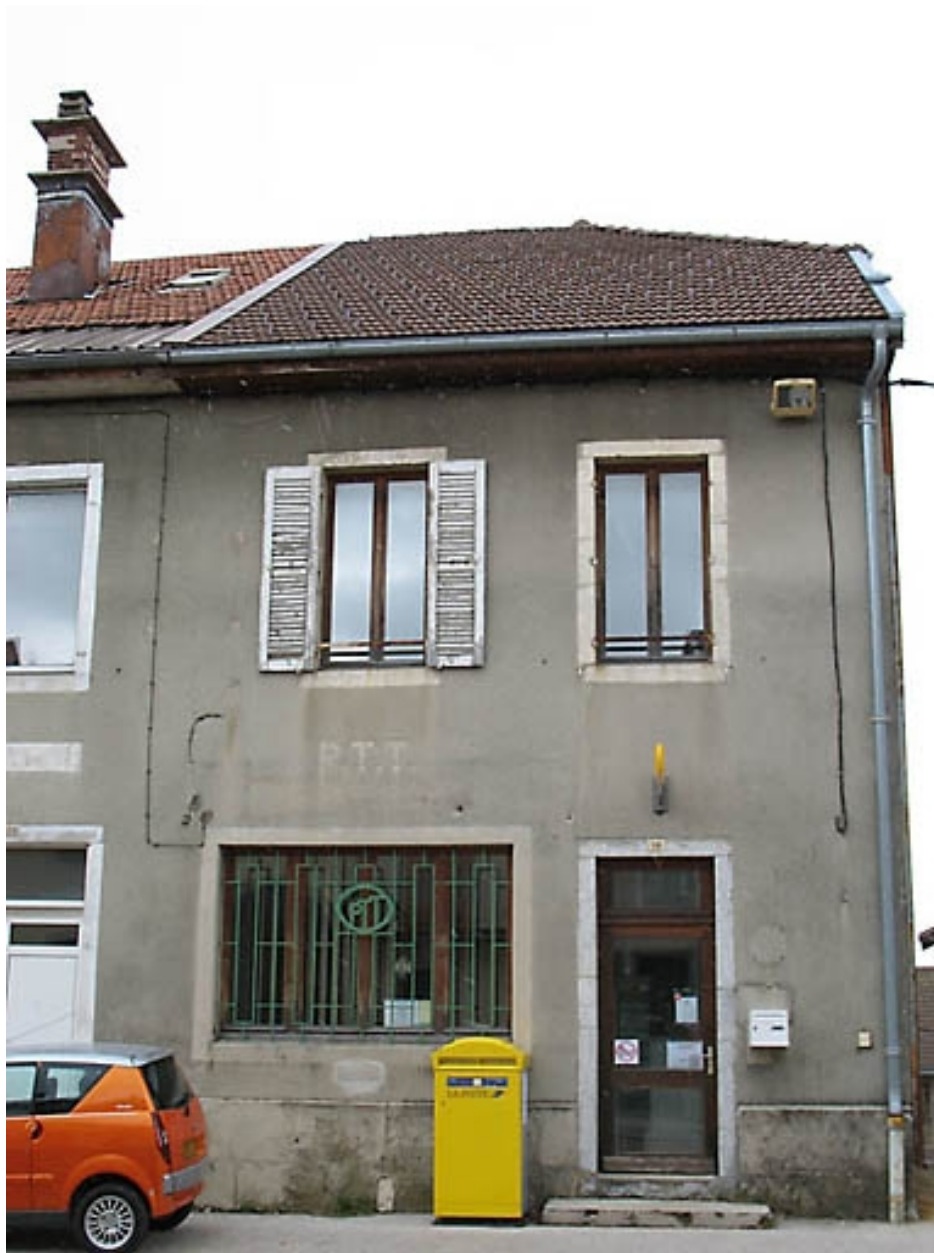
Vue générale de la façade antérieure.
