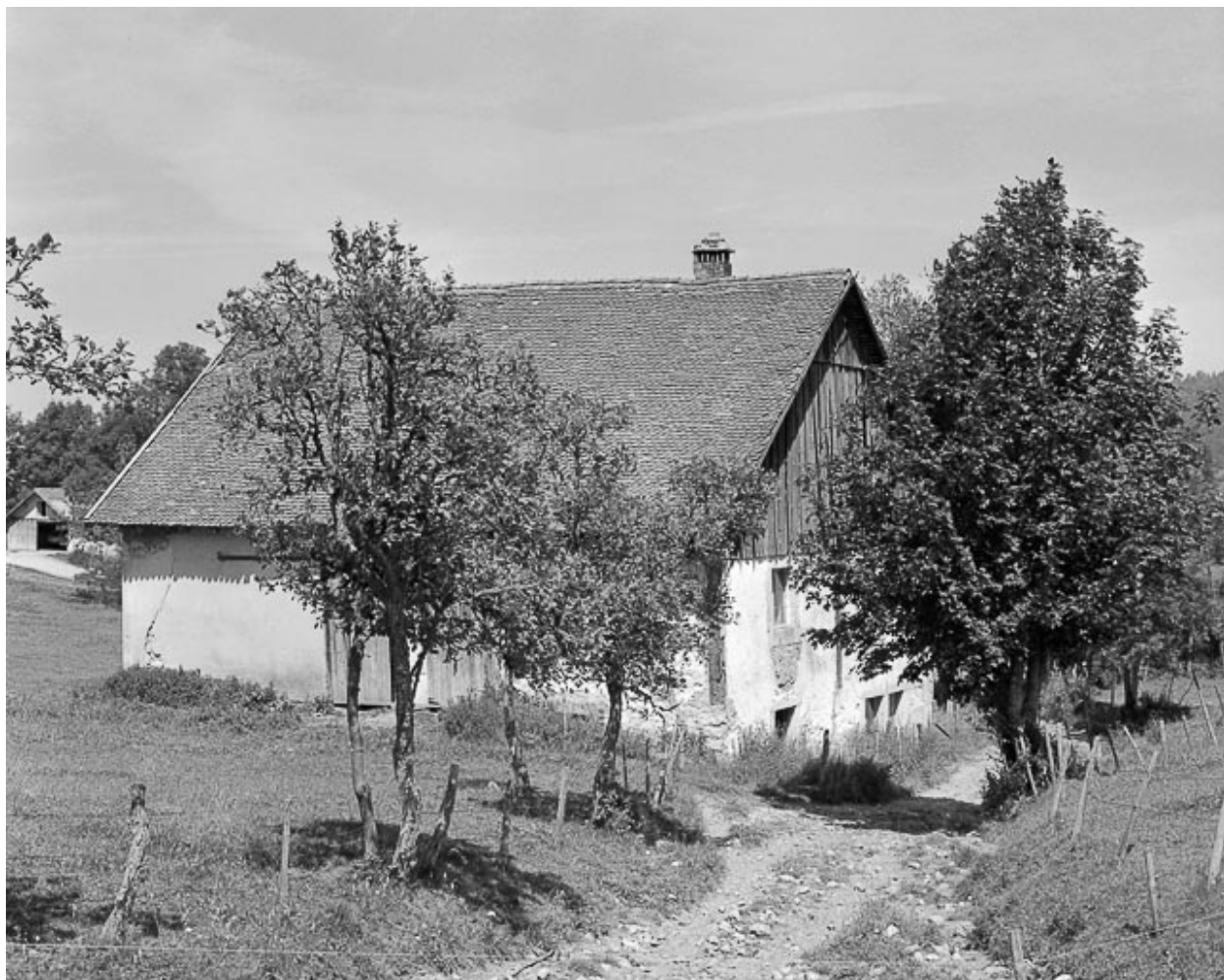
Façade antérieure et latérale gauche.
