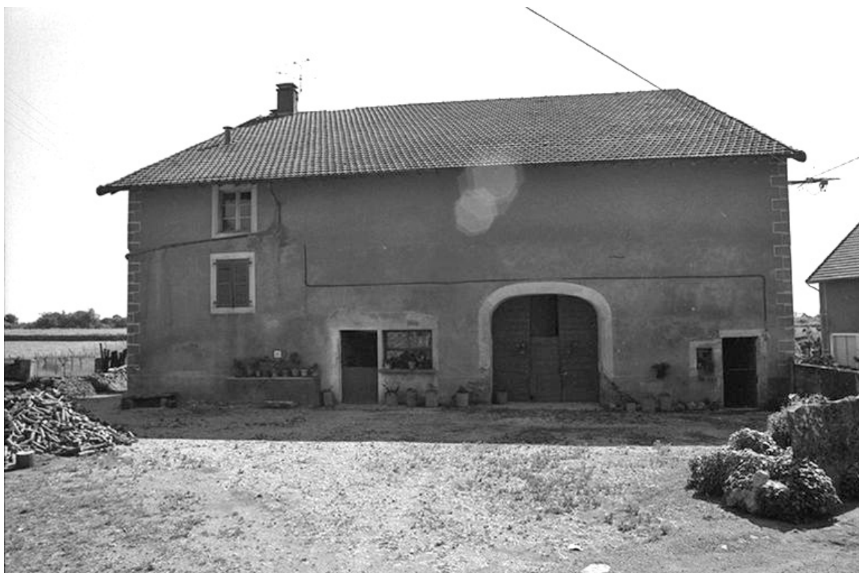
Ferme située le long du chemin de grande communication n° 9 de La Marre à Bonnefontaine.
