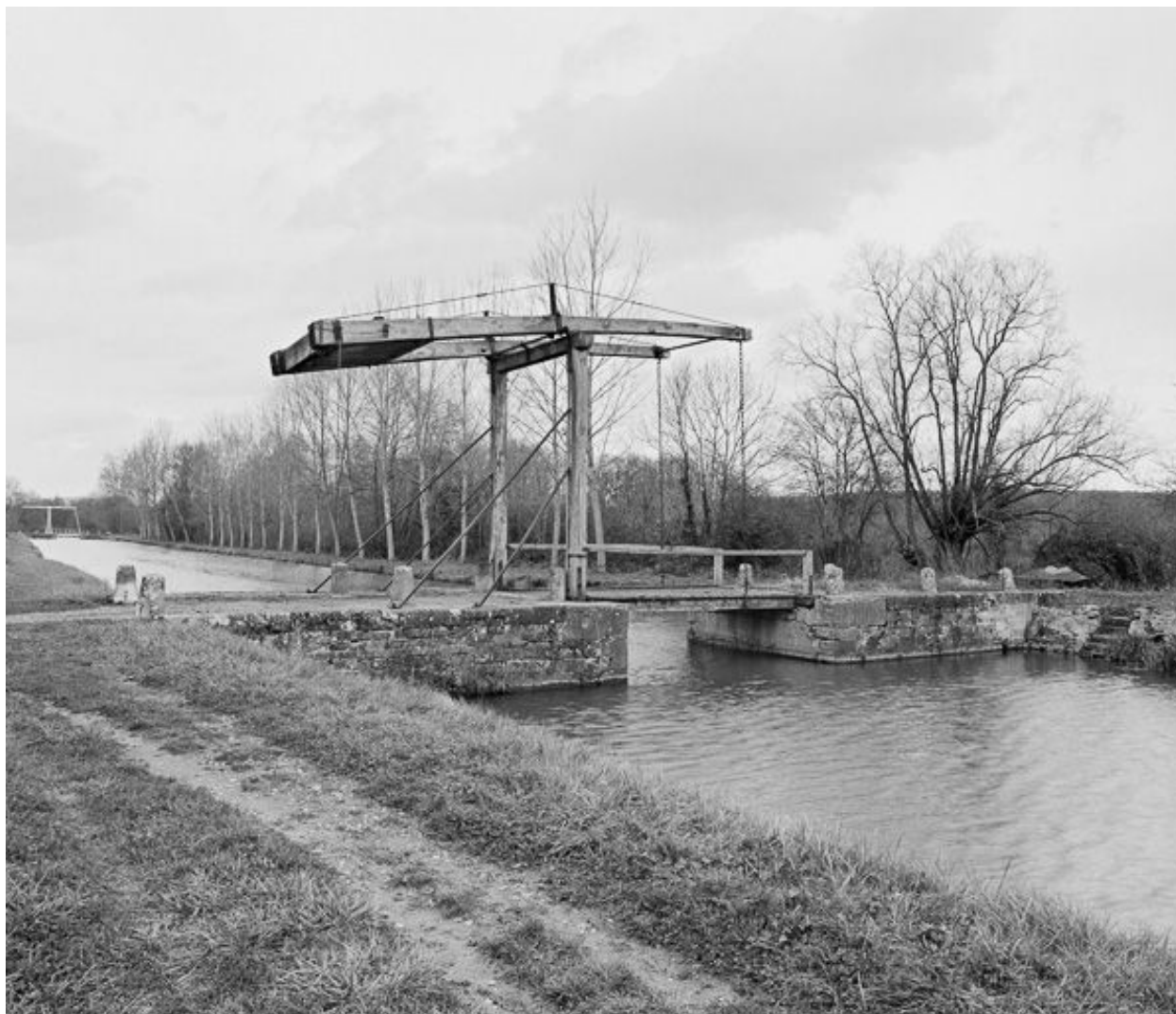
Vue prise de l'amont.
