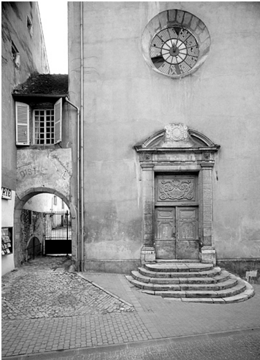
Chapelle : façade antérieure, détail du portail d'entrée avec l'oculus en 1989.
