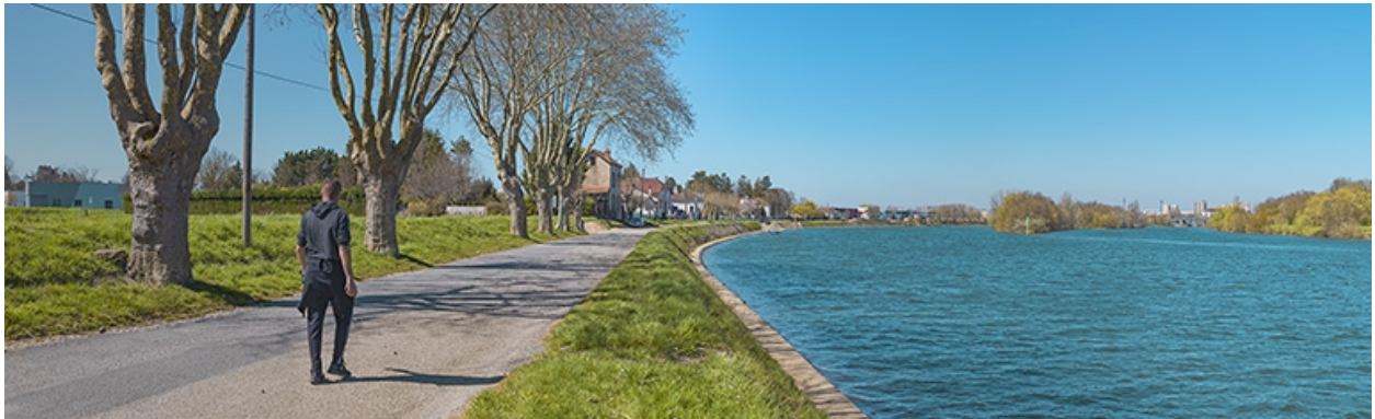
Vue d'ensemble du quai.
