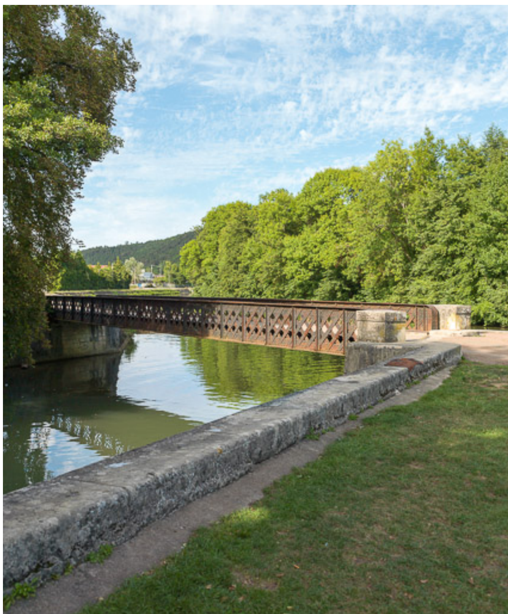
VUe du pont.
