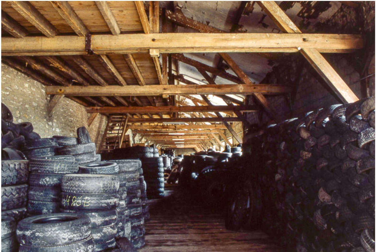
Intérieur d'un quai couvert.
