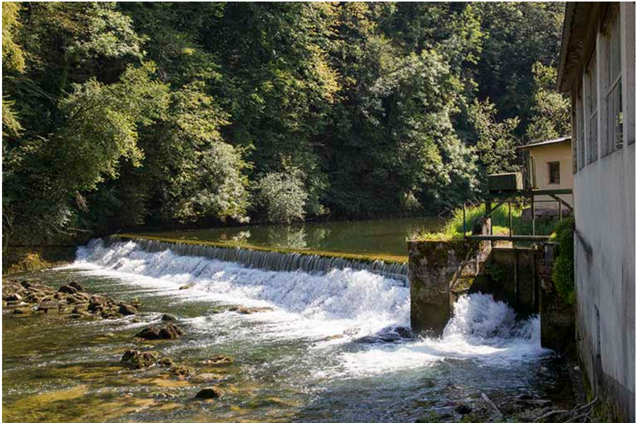
Le barrage et la vanne de décharge.
