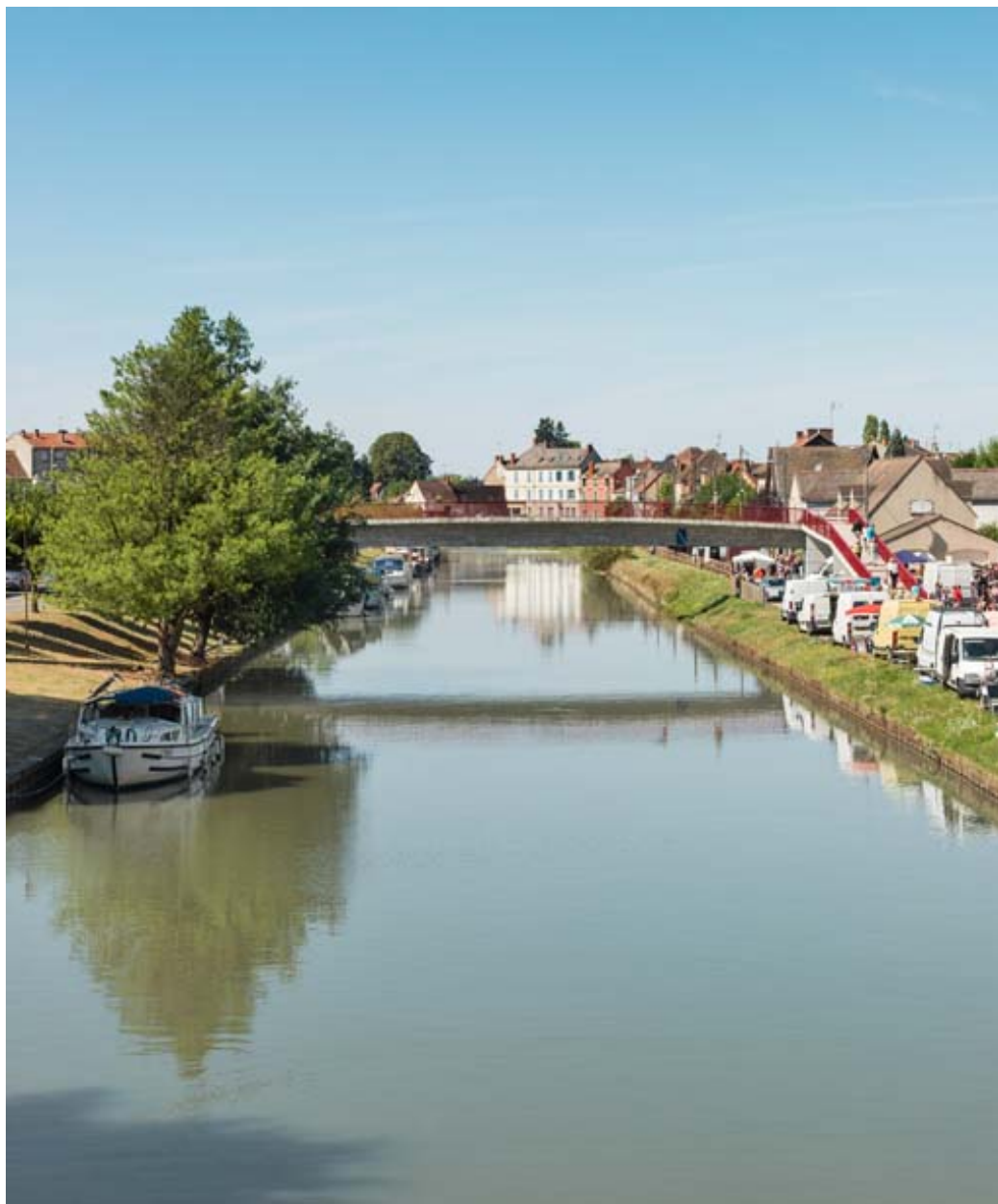
Vue d'ensemble de la passerelle.
