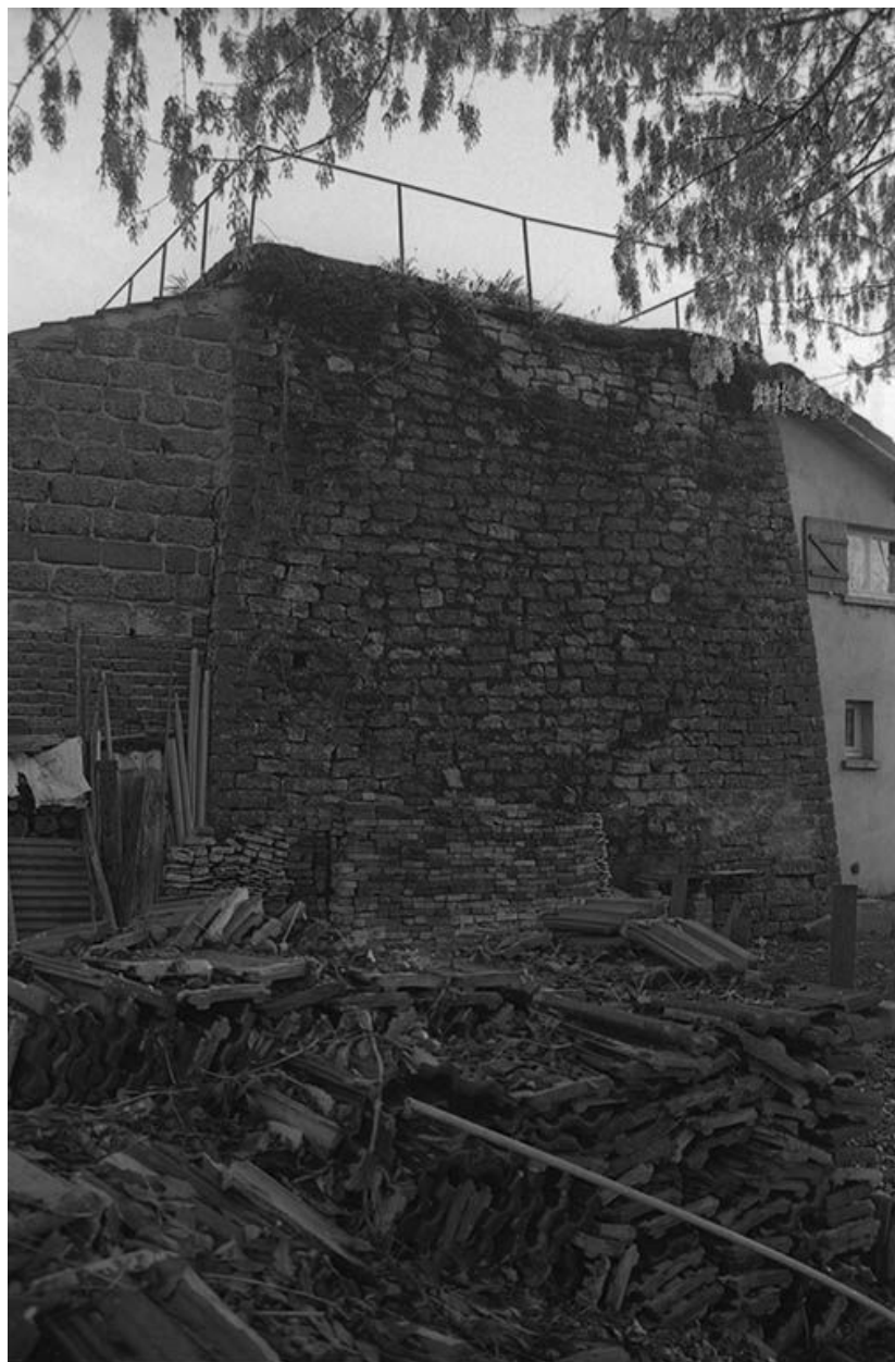
Fours à chaux vus du nord-ouest.
