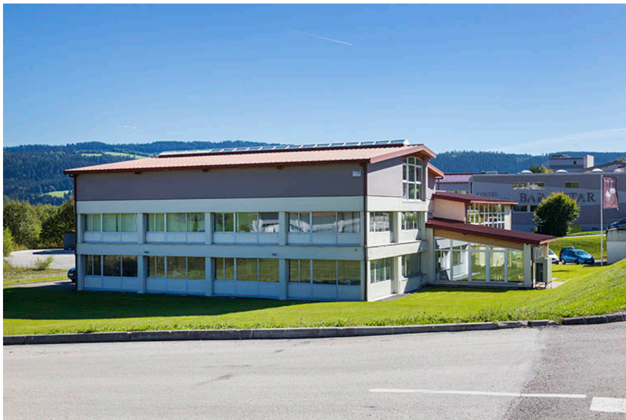
Façades postérieure et latérale gauche.
