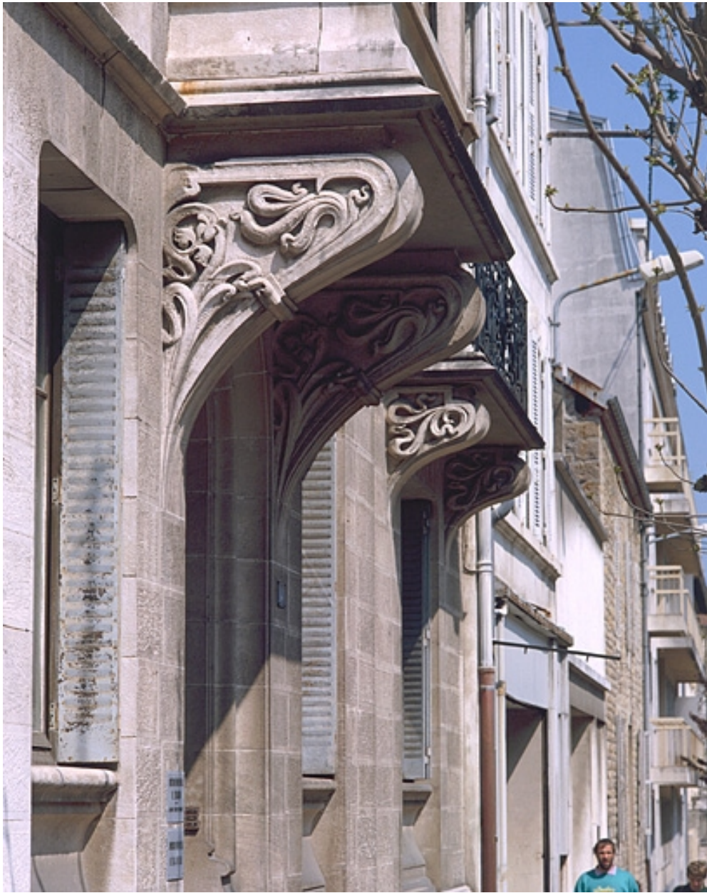
Détail des consoles de l'oriel.
