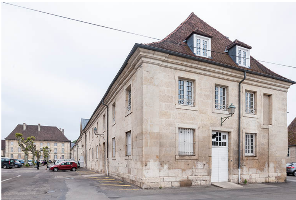
Bâtiment restauration-externat, pignon sud.
