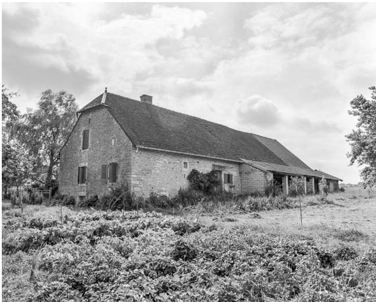
Façade postérieure et pignon droit.
