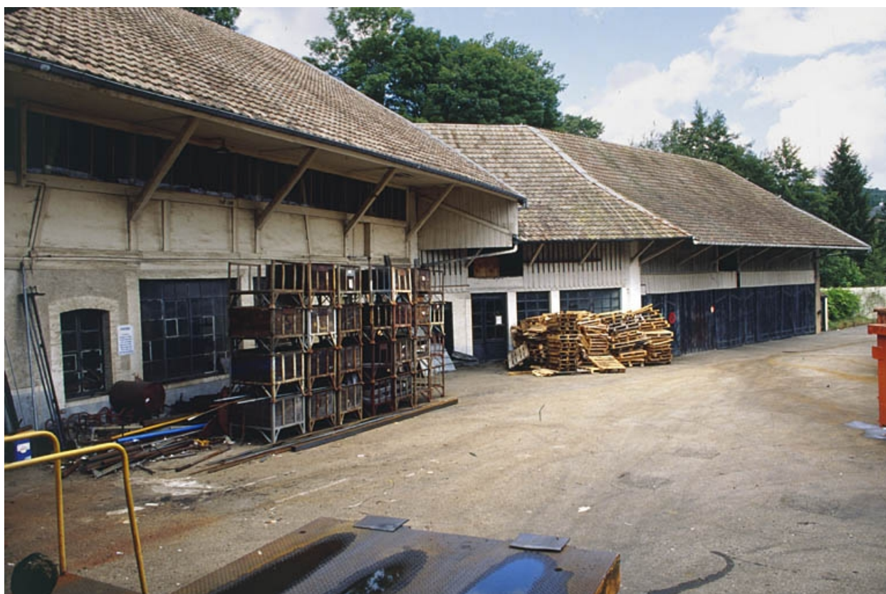
Atelier de réparation, menuiserie et remises.
