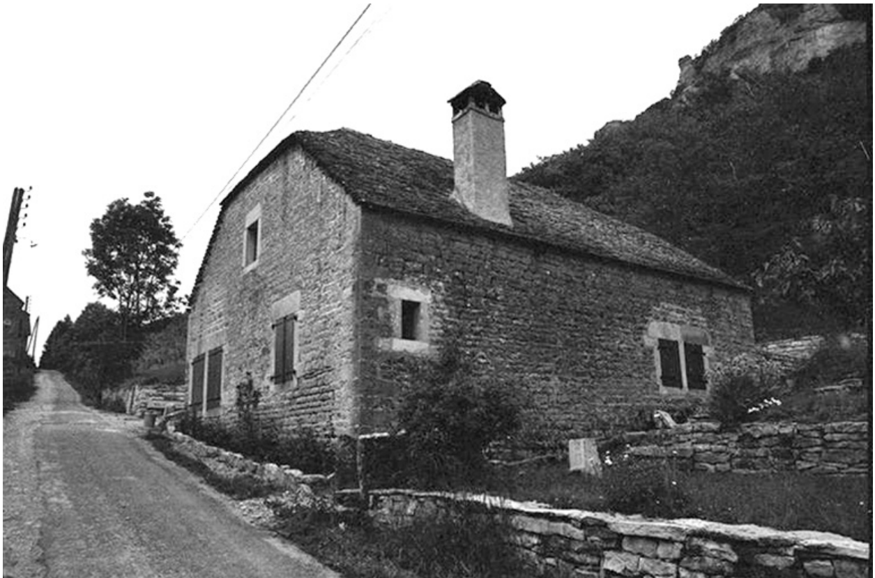
Ferme cadastrée 1960 B 56, située au lieudit La Peyrouse : façade sur rue et façade postérieure. . A noter le toit de laves
