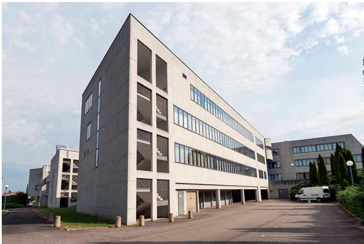
Angle sud, façades sud-est et sud-ouest
