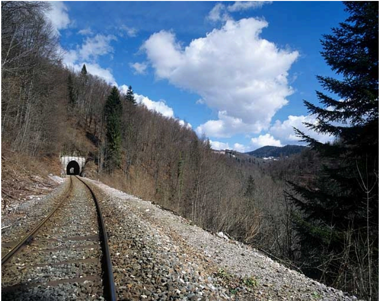
Tunnel du Grépillon : vue d'ensemble, côté La Cluse (sud).
