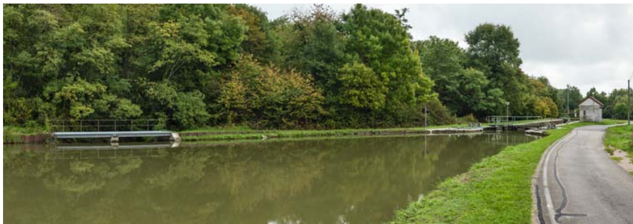
Vue d'ensemble du site d'écluse.
