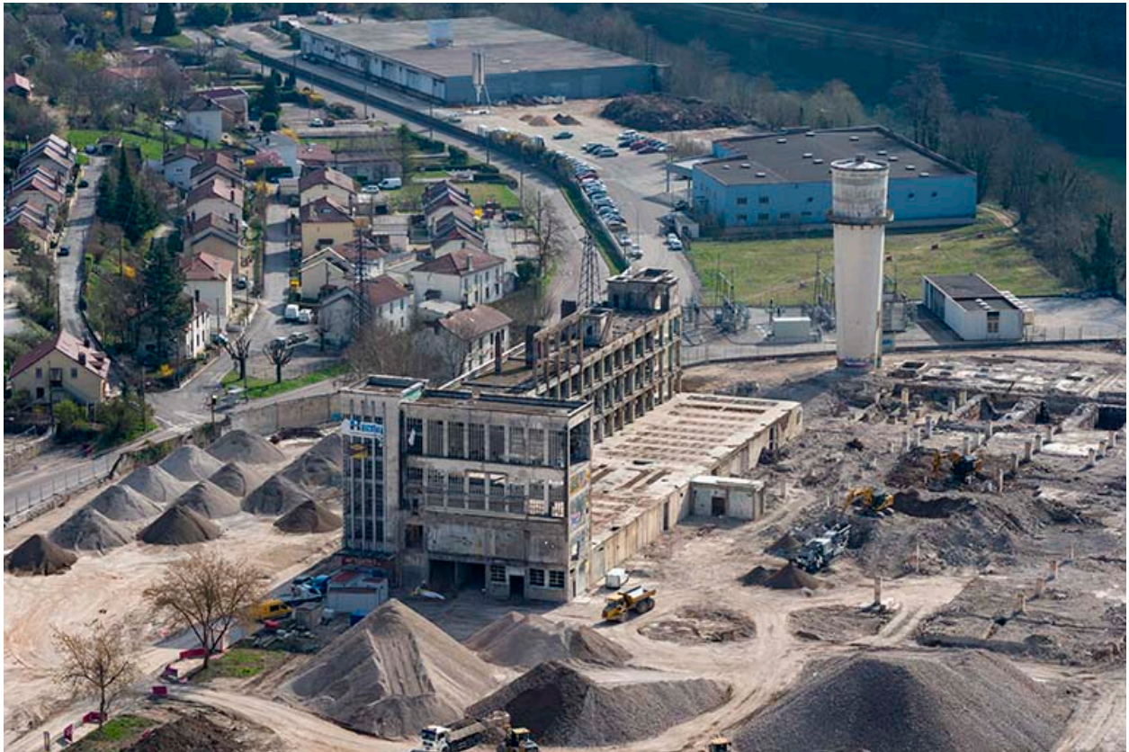
Etat début 2019. Vue plongeante sur le secteur en cours de démolition.
