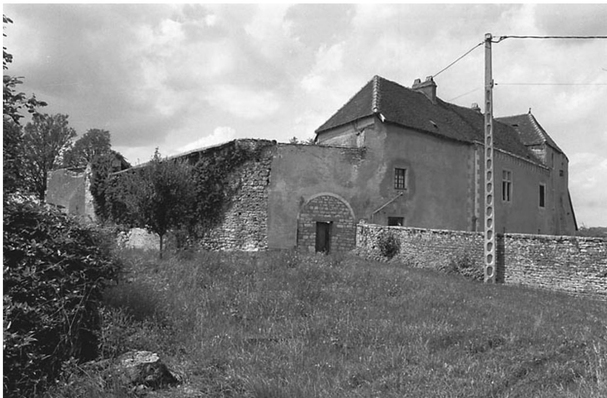
Façades postérieure et latérale droite.
