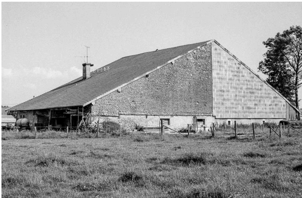
Ferme cadastrée 1938 E 266-267 : façade postérieure.
