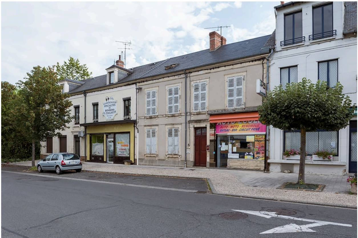
Façade, vue de trois quarts.
