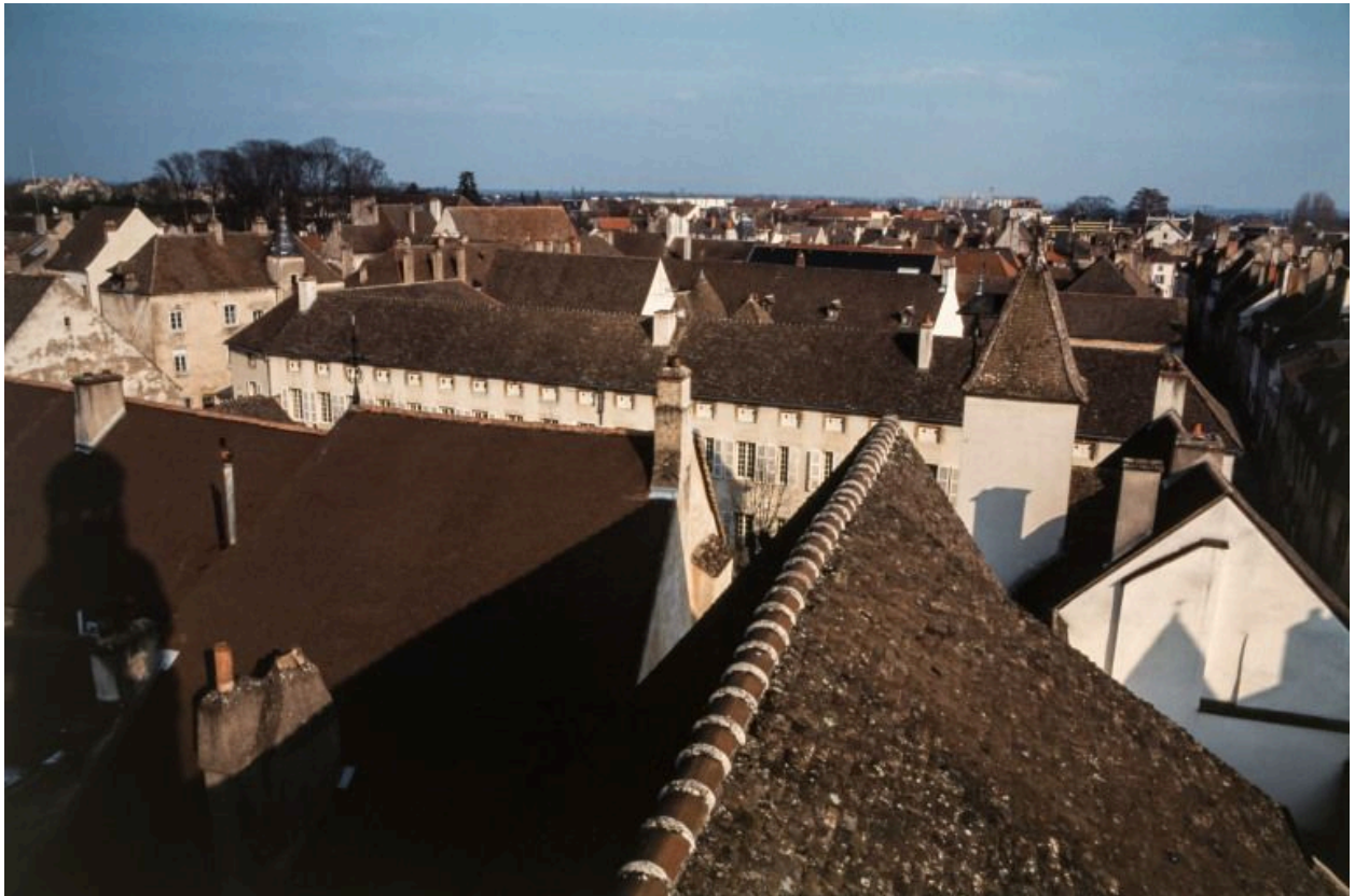
Vue d'ensemble des toitures depuis le clocher de l'église.
