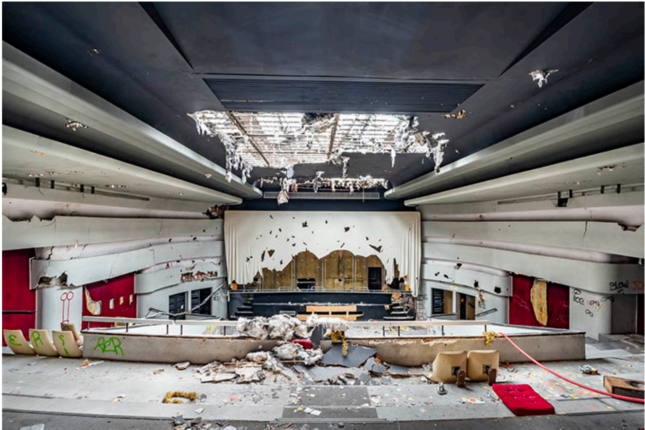
Halle : grande salle, vue depuis le balcon.
