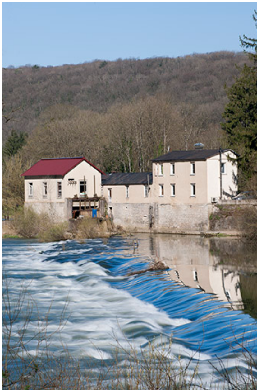
Vue depuis la rive gauche du barrage.
