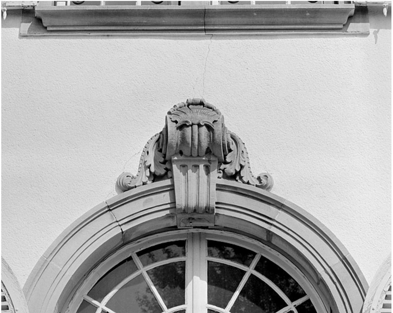
Façade sud. Détail d'une fenêtre du rez-de-chaussée.
